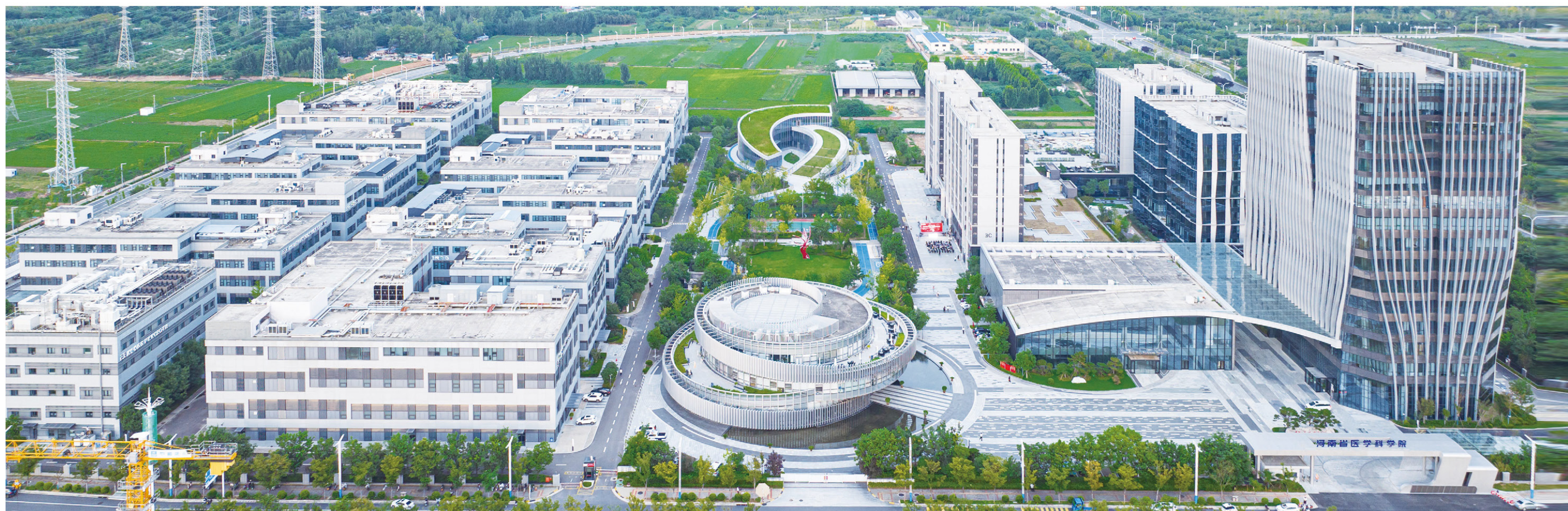
助力中原医学科学城建设，推进院产城深度融合 刘畅 摄
