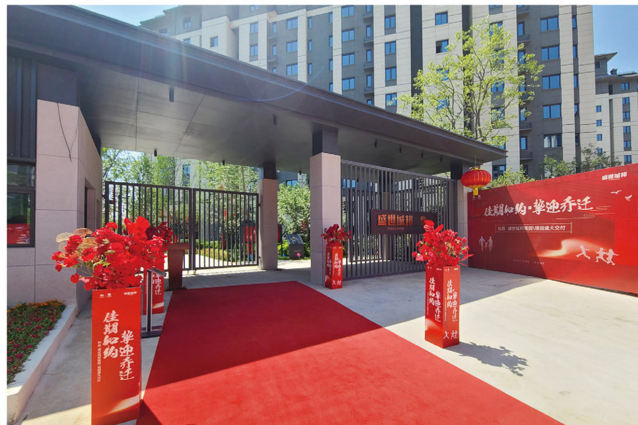
兴港和昌盛世城邦项目交付 孙钰祯 摄
