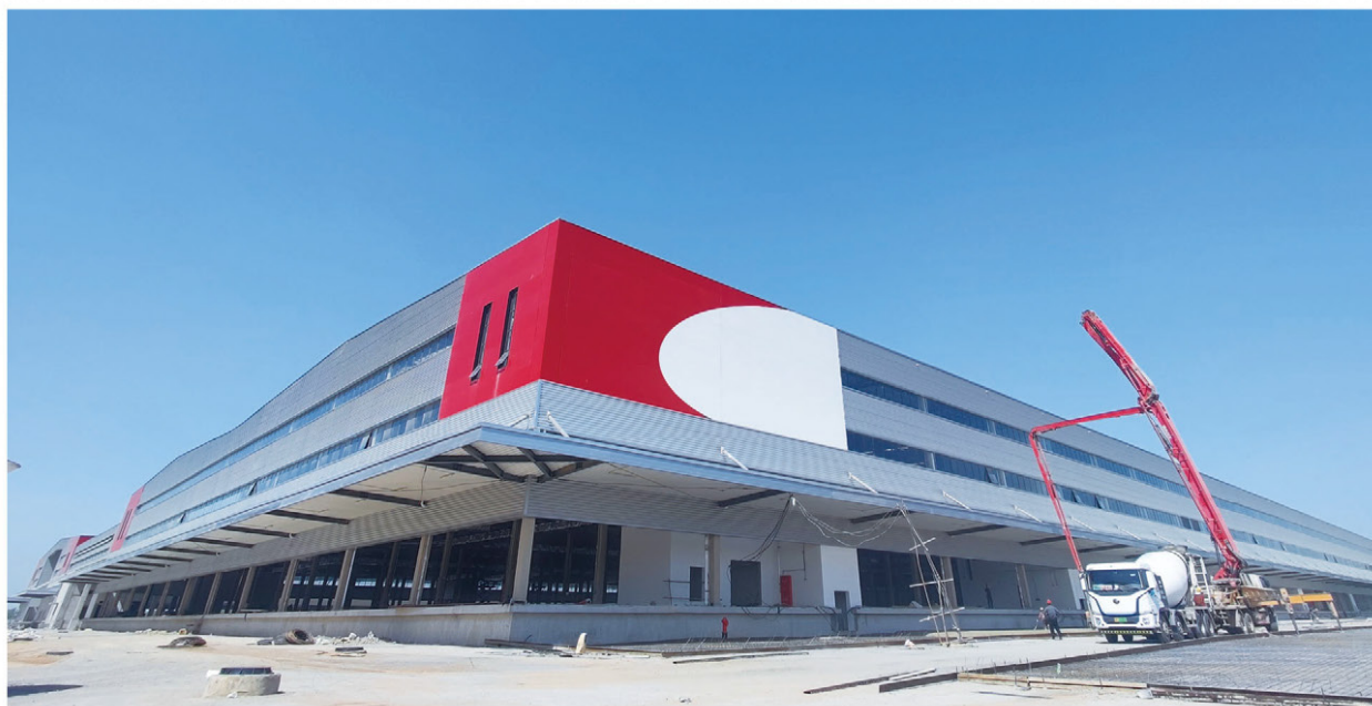
郑州临空物流分拨中心项目1号2号分拨中心顺利通过主体验收 徐京晶 摄
